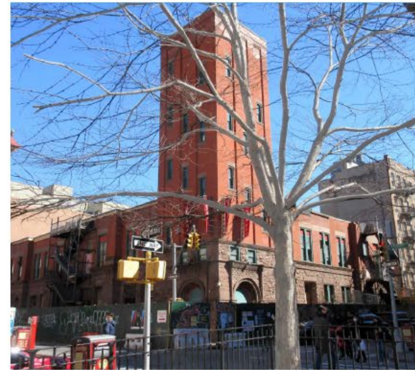
Existing Condition 現有狀況
