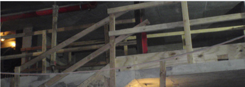
Защита проема в перекрытии
