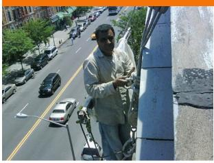
고용주는 난간이 없는 지지형 비계에서의 작업 또는 조절형 현수 비계 작업을 하는 작업자에게 추락 방지장치를 제공해야 합니다. **안전벨트 착용만으로는** 충분하지 않습니다! 제대로 작동하려면 작업자는 **안전한** 구명줄에 연결되어 있어야 합니다.
