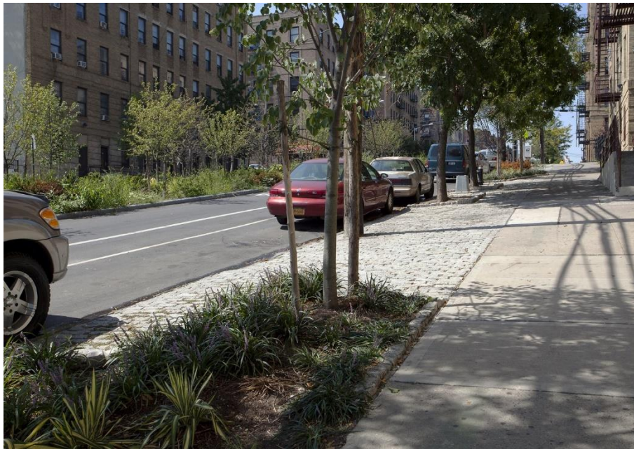
VISTA DE CALLE DE JARDINERAS PARA AGUAS PLUVIALES EN LAFAYETTE AVE, BRONX
