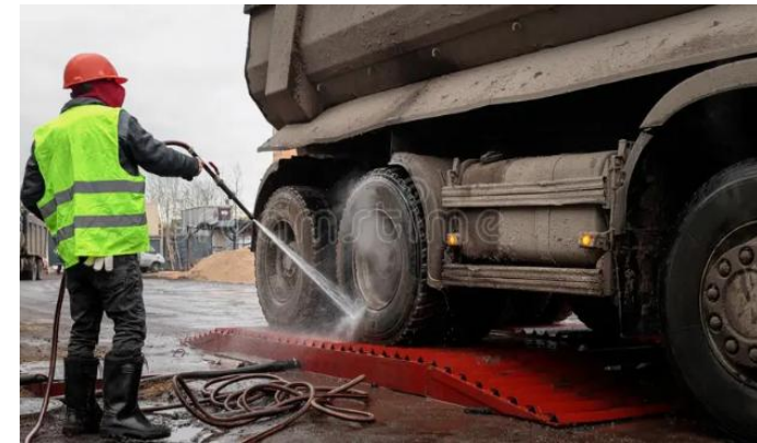
Wheel Wash Area 洗輪區
