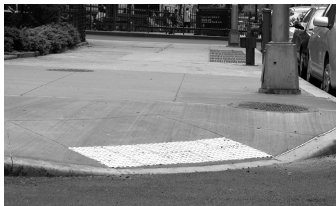
安裝路緣石和盲道使紐約市變得更加便利。
