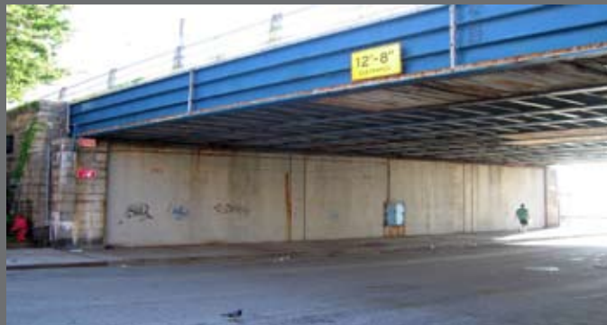
Condición actual del puente Bay Ridge Avenue
