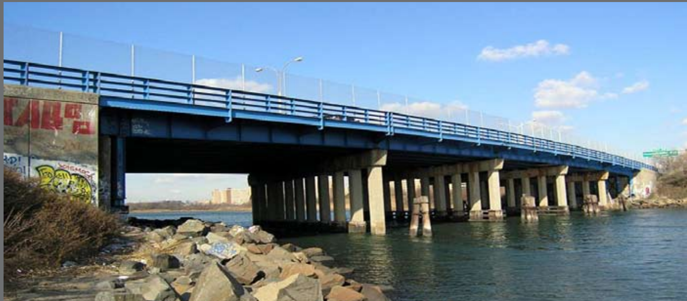
Puente Fresh Creek Basin actual
