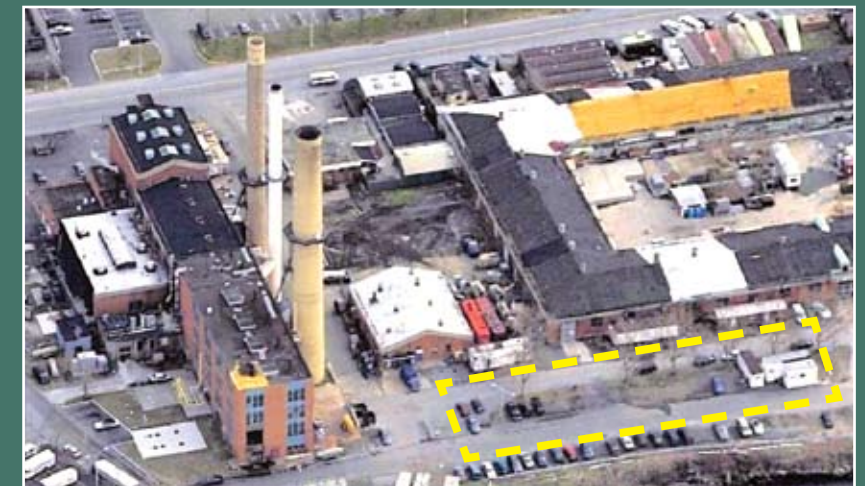
Figure 2: View of project site, looking southeast Figura 2: Vista del sitio del proyecto, mirando al sudeste
